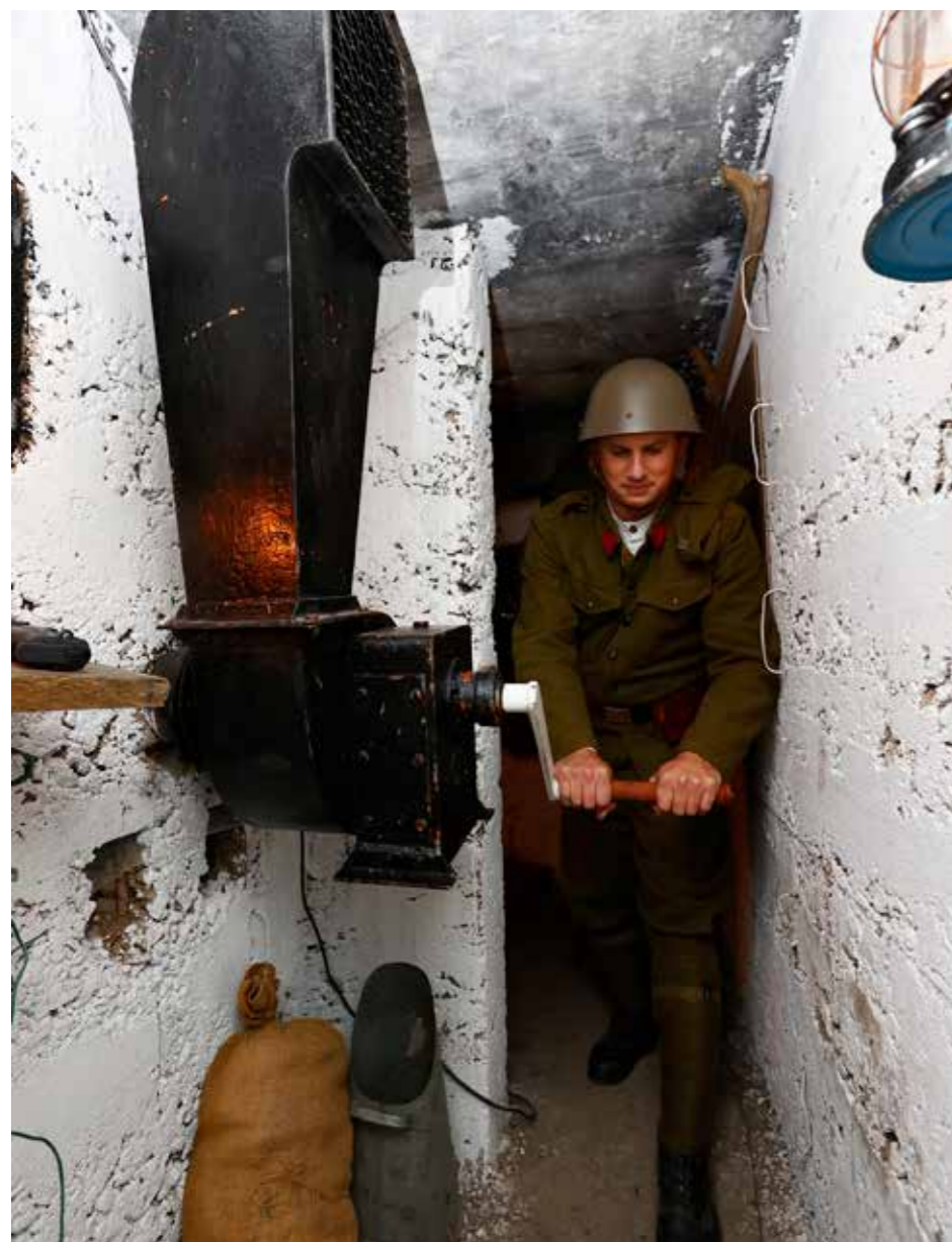
Muzeum je vybaveno i ventilátorem, který během střelby odvádí spaliny.
