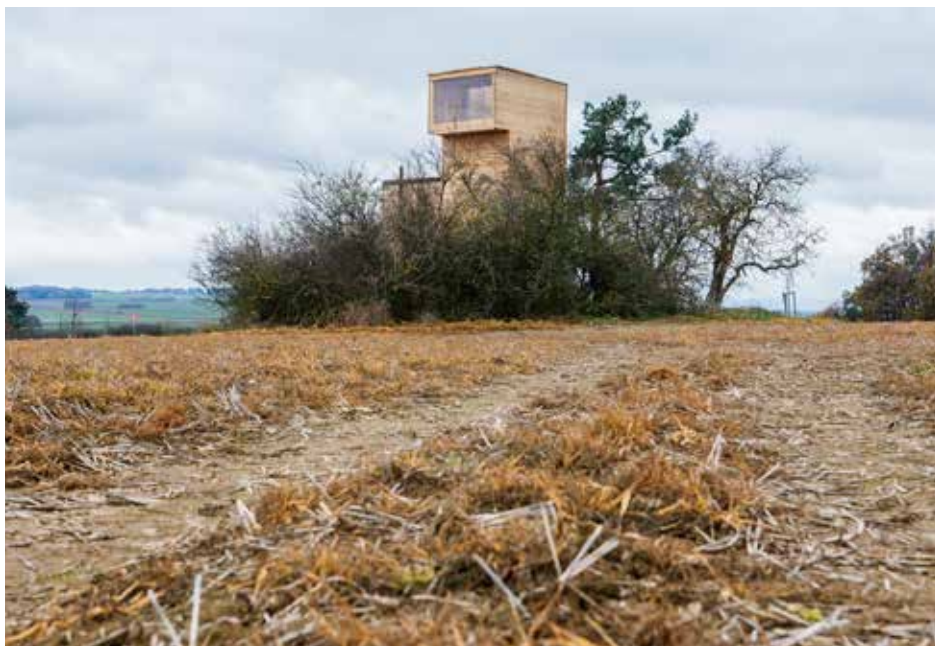
Nástavba na řopíku vyrůstající z křoví dobře zapadá do krajiny u Vratěšína.
